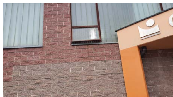
Kopelitna zasteklizev zahodne fasade telovadnice vgrajeno v železne okvirje brez termočlena. U vrednost 4-6 W/m 2 K
