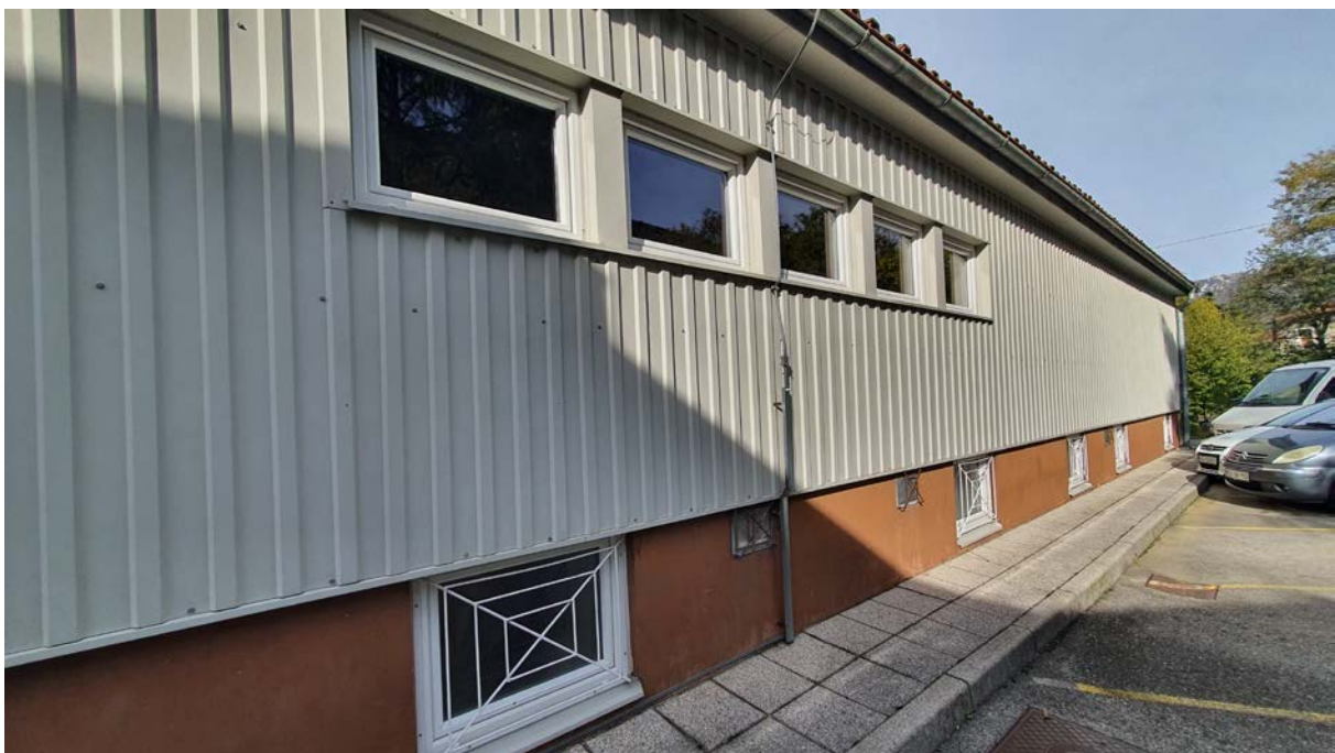
Vzhodna fasada oblečena v trapezno pločevino, spodaj je viden beton, ki je samo pobarvan brez toplotne izolacije. Plastična okna so bila zamenjana leta 2005. Pločnik okoli telovadnice je iz pranih betonskih plošč.
