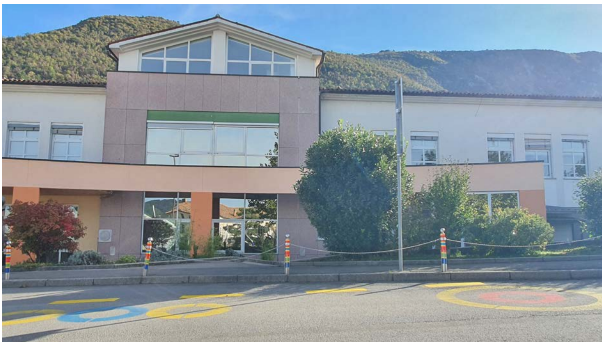
Zahodna fasada z plinobetonskimi ploščami
