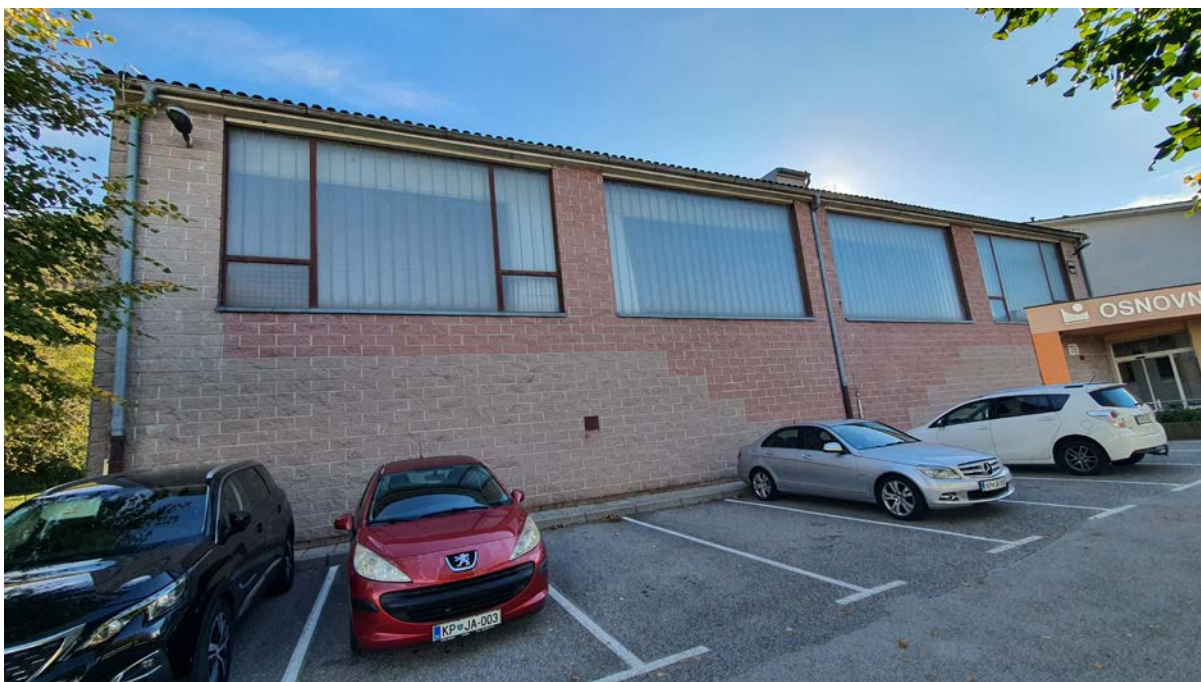
Kopelitna zasteklizev zahodne fasade telovadnice vgrajeno v železne okvirje brez termočlena. U vrednost 4-6 W/m 2 K
