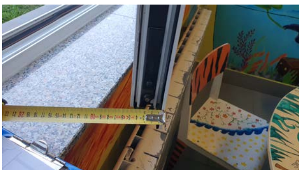
Aluminijasta okna iz leta 1996 v izredno slabem stanju, ki bij jih bilo potrebno zamenjati
