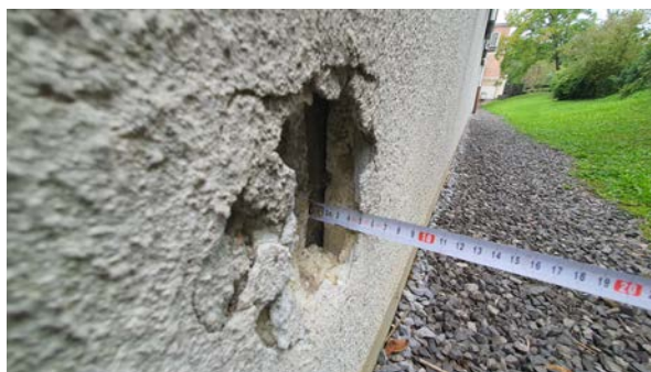
Zunanje AB stene so obložene samo s 4 cm EPS izolacije.
