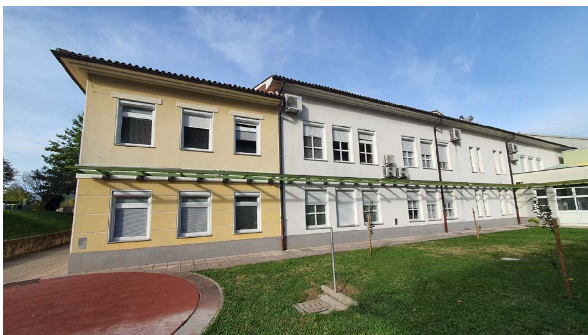
Vzhodna fasada s 7 klima napravami na fasadi in jekleno pergolo s 3 lučmi. Strelovod je voden podometno.
