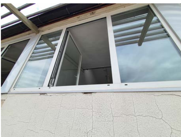
Tesnitev in toplotna prevodnost je pod vprašajem
