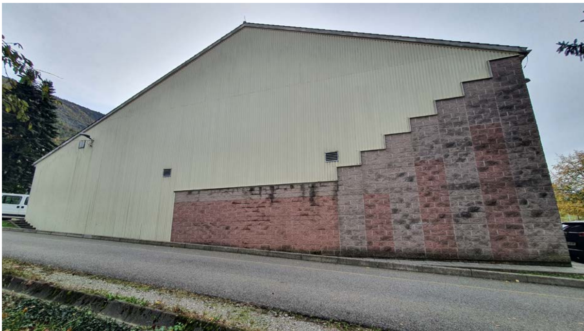
Severna fasada oblečena v umetni kamen in trapezno pločevino
