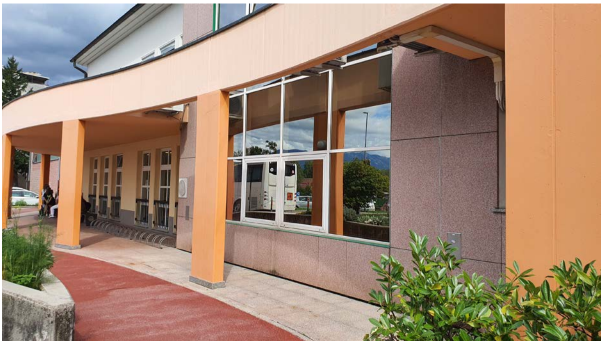
Celostenska fasadna zasteklitev, ki omogoča zamenjavo samo stekel s trislojnimi stekli
