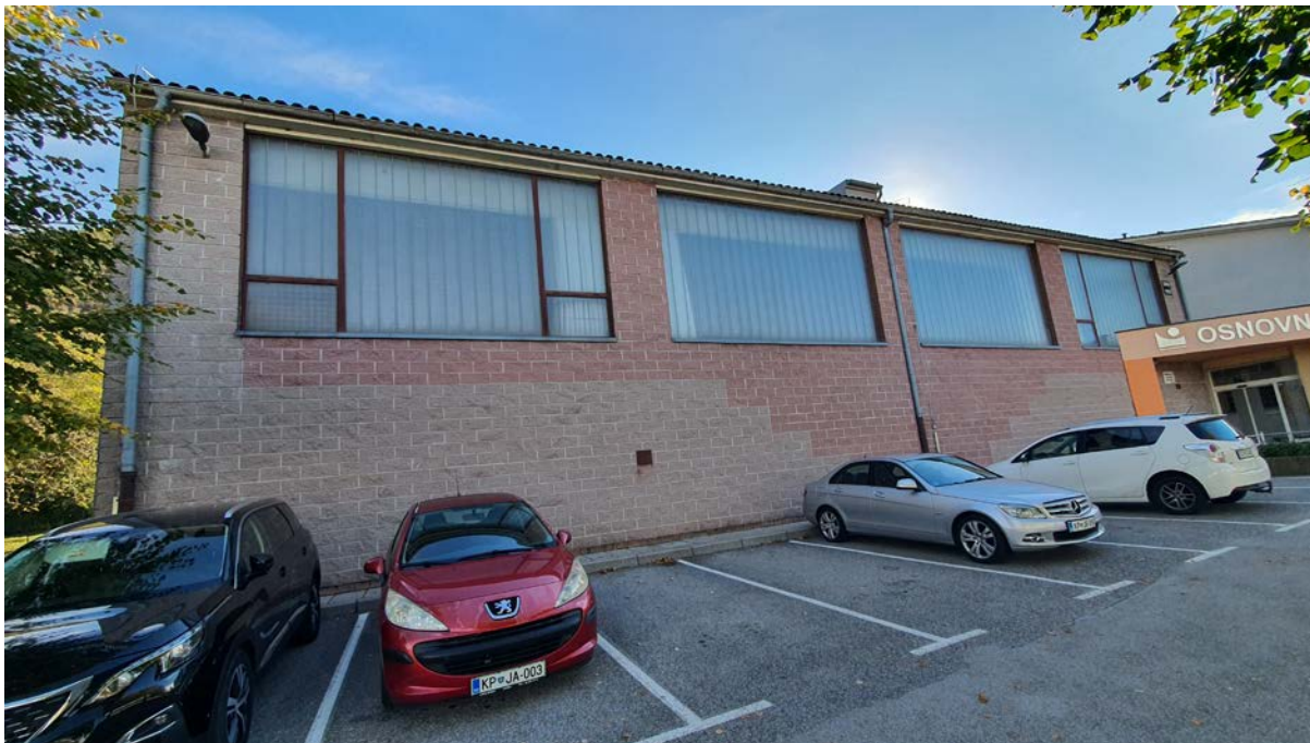
Zahodna fasada telovadnice oblečena z umetnim kamnom. Zasteklitev je iz kopelit stekla, ki ne ustreza minimalnemu standardu o toplotni prevodnosti steklenih površin.
