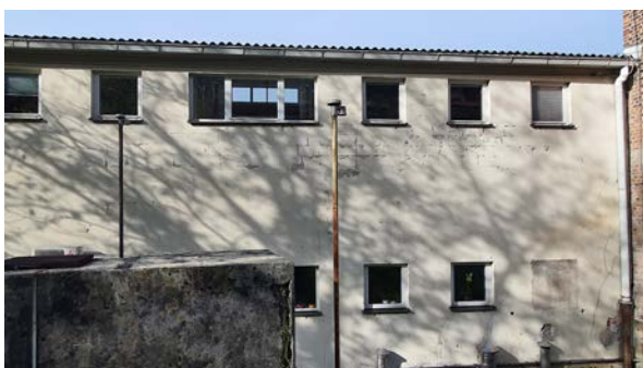
Vidno odpadanje obloge siporeksa na vzhodni fasadi.
