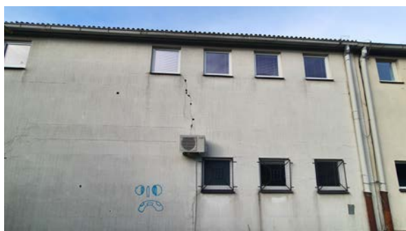
Vidne poškodbe fasade, kjer na določenih mestih manjka EPS izolacija. Pod vprašajem je stanje EPS izolacije pod zaključnim ometom.
