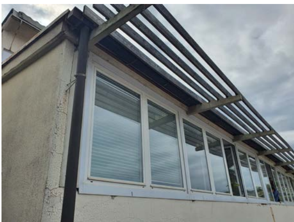
Vidno odpadanje obloge siporeksa na zahodni fasadi pod okni.
